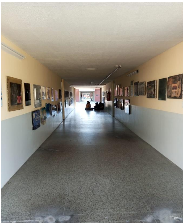
Figura 15 – Revitalização do bloco de ciências contábeis (Depois)
