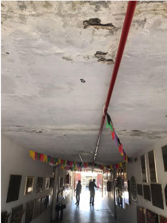
Figura 14 – Revitalização do bloco de ciências contábeis (Antes)
