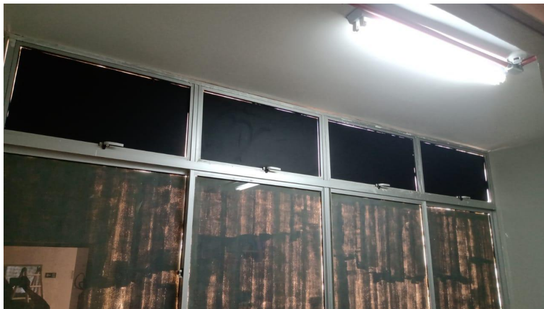
Figura 19 – instalação de película blackout (depois)
