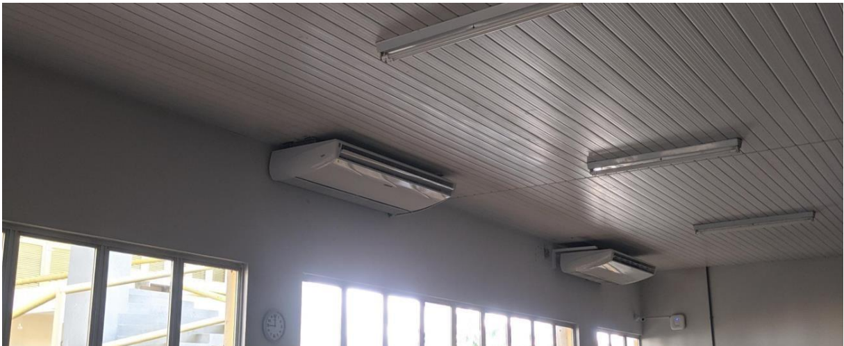
Figura 38 – Troca de condicionadores de ar do RU
