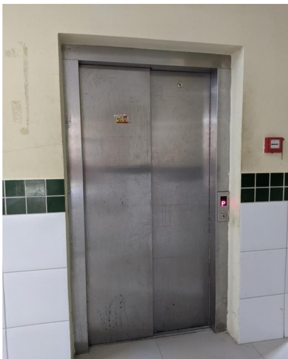
Figura 4 – Revitalização dos elevadores (ANTES)
