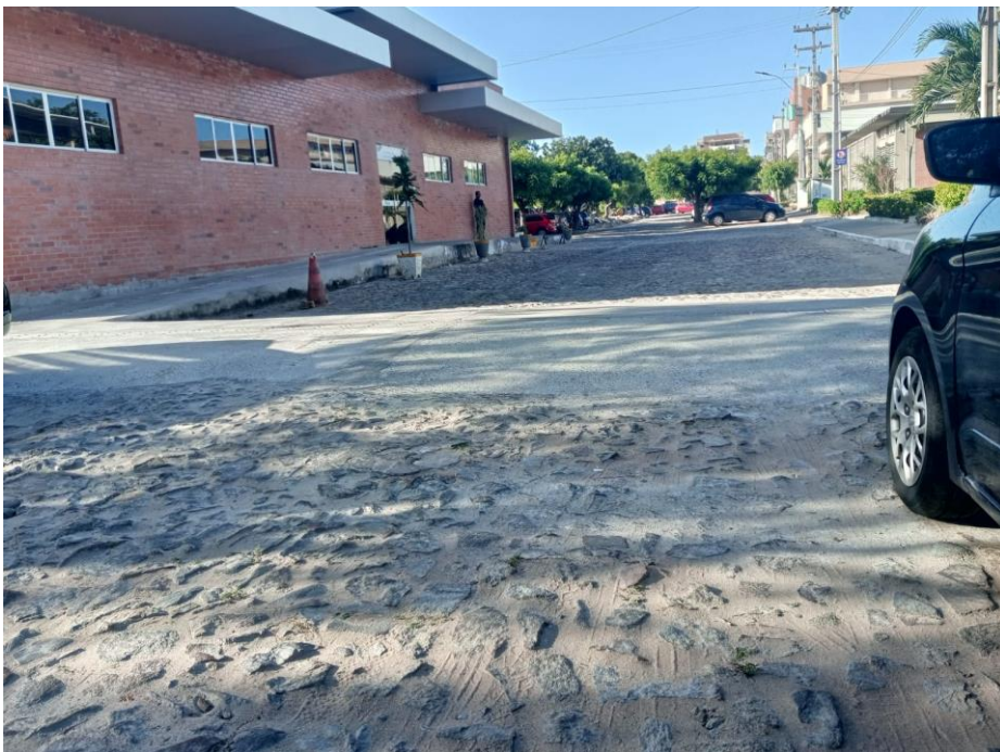
Figura 36 – adequação de lombadas (depois)
