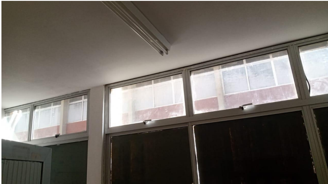
Figura 18 – instalação de película blackout (antes)
