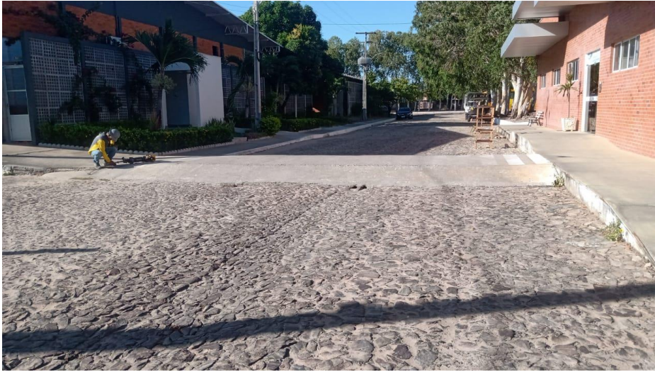
Figura 35 – Adequação de lombadas (antes)
