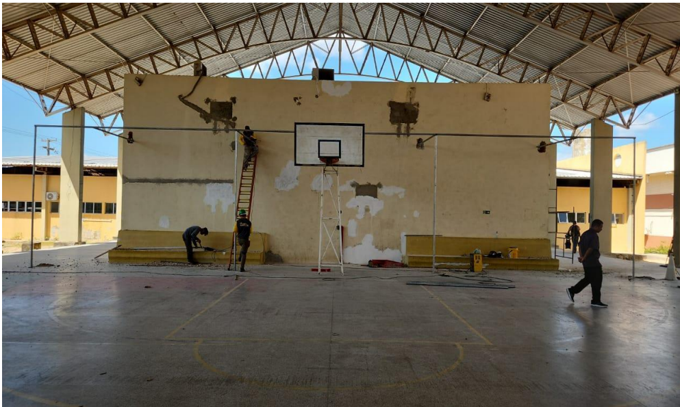
Figura 9 – revitalização da quadra poliesportiva (antes)
