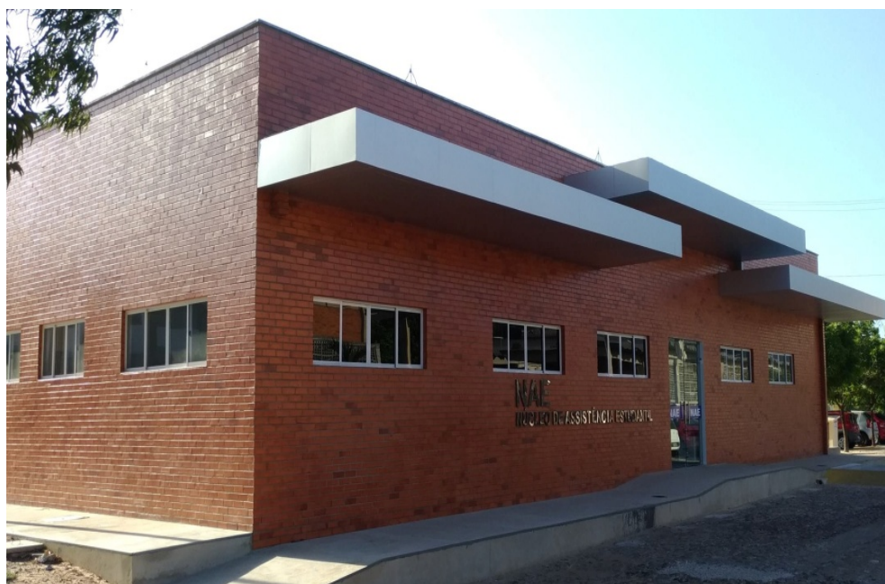
Figura 4: Prédio da PRAE
