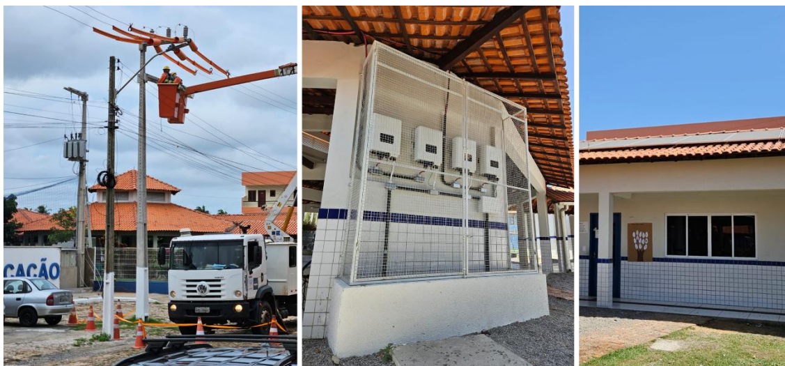
Figura 18 - Implantação de subestação e projeto de eficiência energética na Escola de Aplicação
