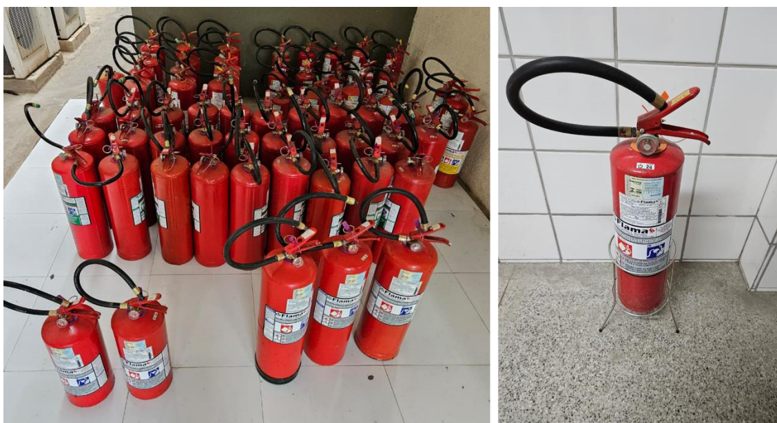
Figura 21 - Manutenção e adequação dos sistemas de combate a incêndio
