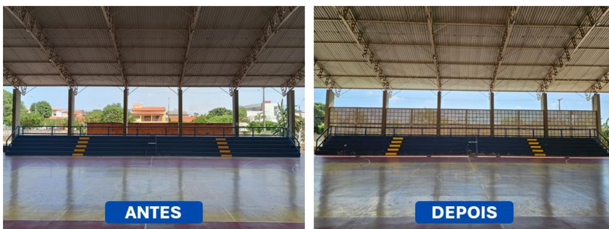
Figura 19 - Implantação de cobogós na arquibancada leste da Quadra de Esportes
