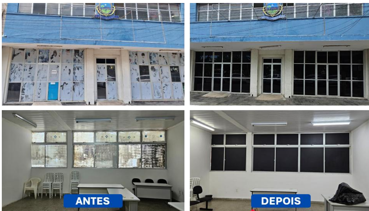
Figura 23 - Aplicação de películas de controle solar em ambientes acadêmicos
