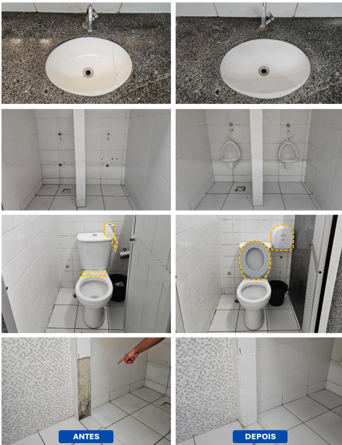
Figura 26 - Manutenção de banheiros de grande circulação
