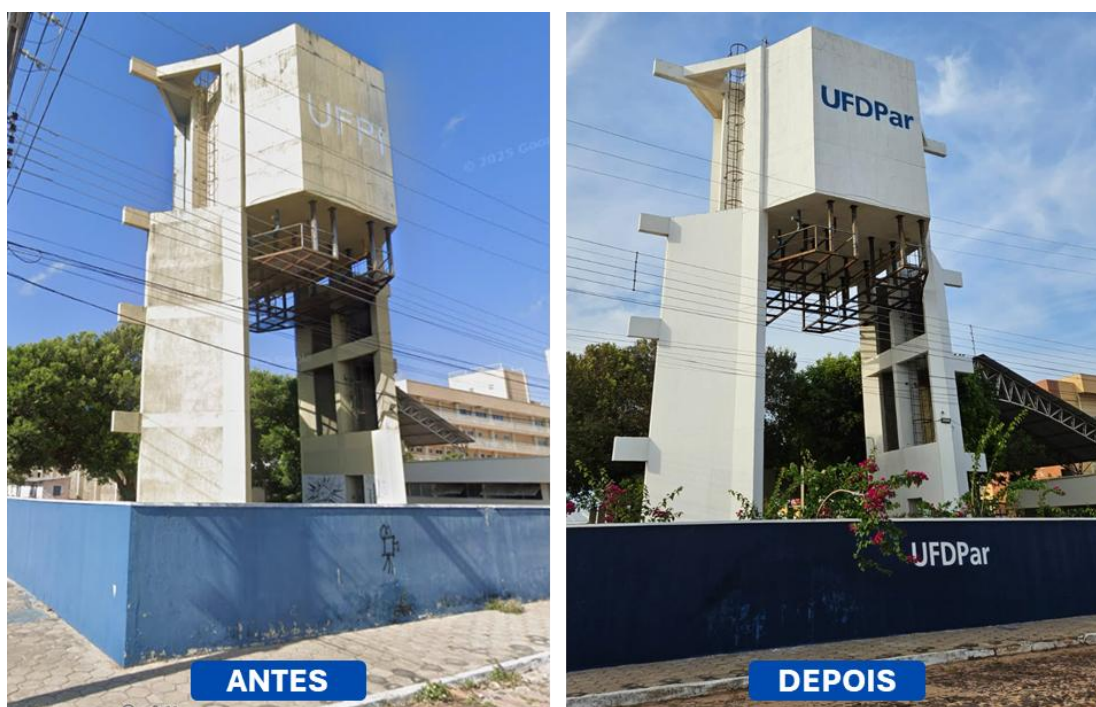
Figura 15 - Pintura da Caixa d'água e do muro
