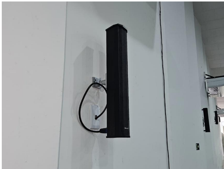
Figura 6 - Instalação de sistema de som nos auditórios
