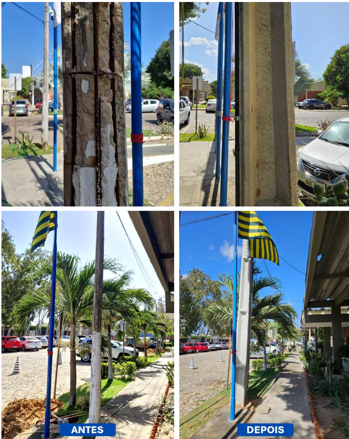
Figura 20 - Substituição de postes de iluminação degradados
