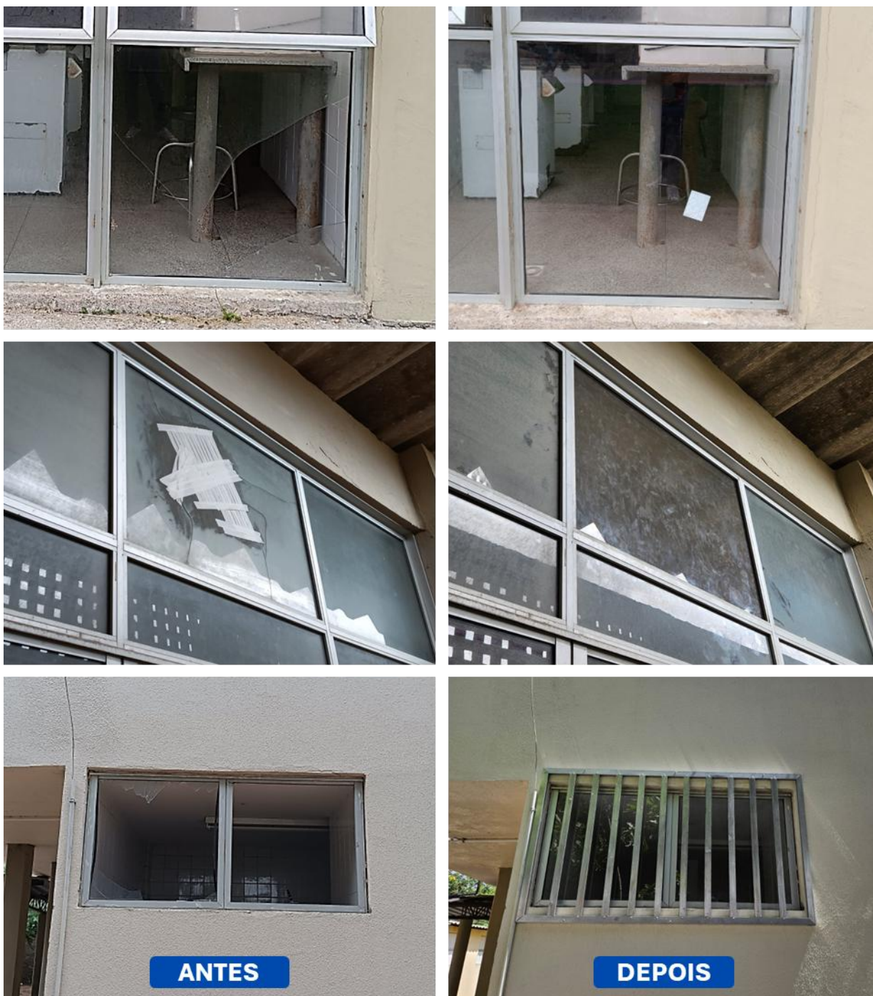
Figura 28 - Substituição de vidraças danificadas
