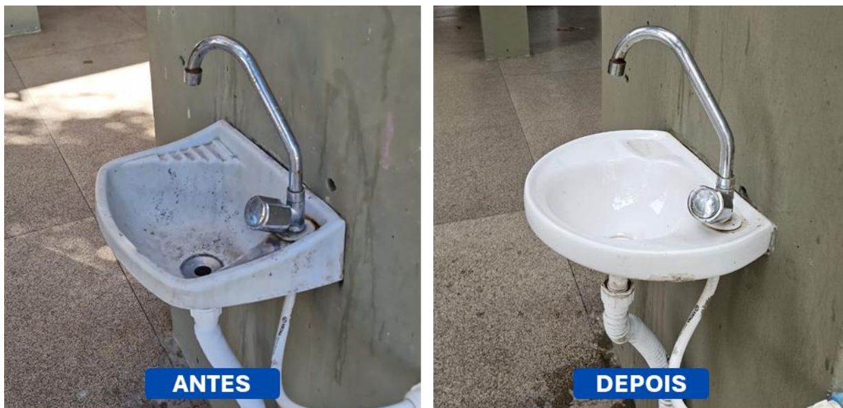
Figura 27 - Substituição dos lavatórios de plástico por lavatórios de louça
