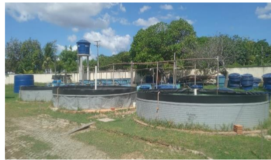
Figura 8. Tanques circulares de 20 m 3 .
