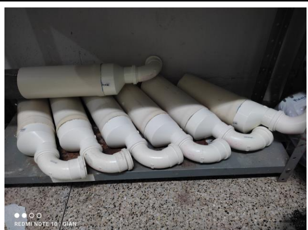
Figura 53: Estruturas internas do pré-filtro montadas
