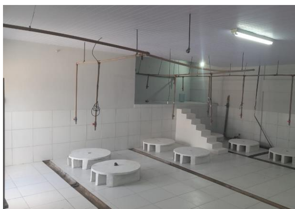
Figura 11- C. Parte interna da conclusão da reforma do Galpão.
