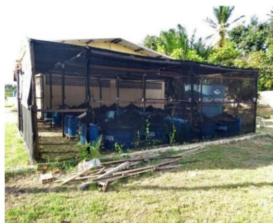
Figura 11- D. Berçário da Estação de Aquicultura
