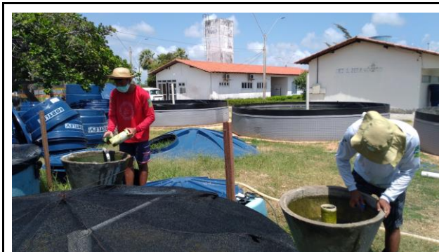
Figura 36: Limpeza de decantadores do Projeto Rzero
