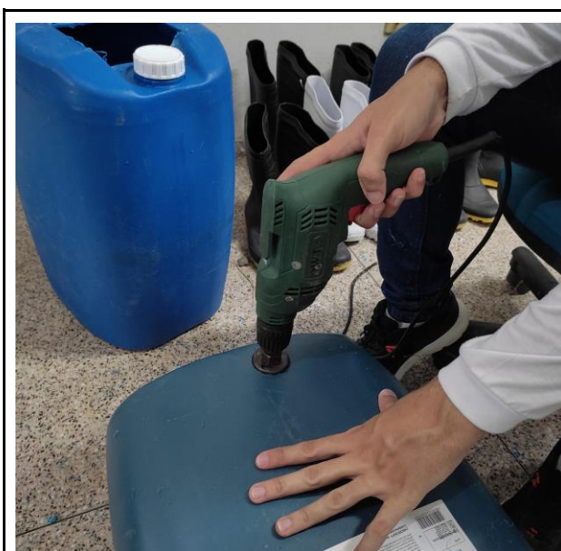
Figura 54: Furos sendo feito na bomba para encaixe dos canos
