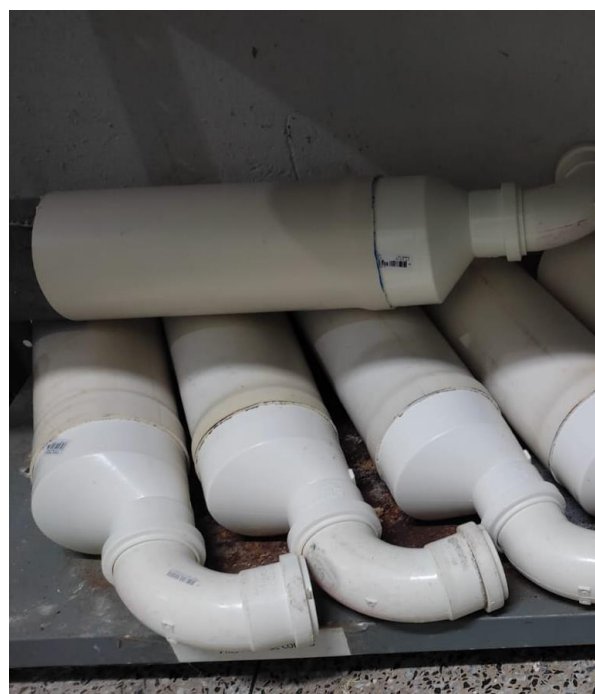
Figura 67: Estruturas internas do pré-filtro montadas
