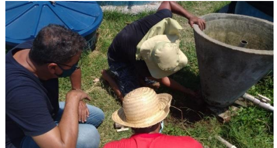
Figura 36: Conserto de um dos decantadores
