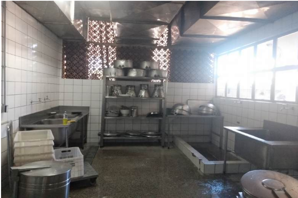
Fig. 11: Área de Lavagem de Utensílios da cozinha
