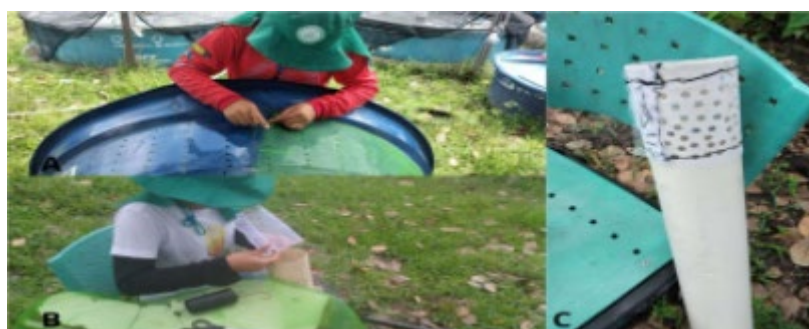
Figura 03: Instalação da tela na caixa de 500 L e overflow. Fonte: Henrique Firmino Araújo Oliveira
