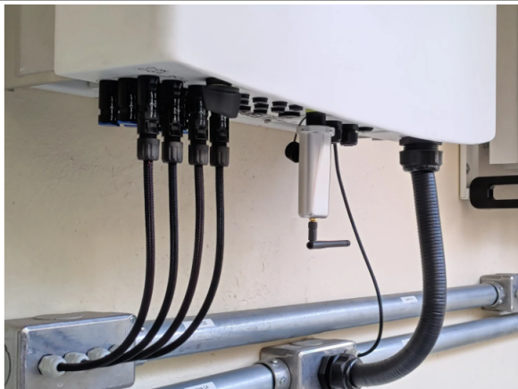
Figura 12: Modelo de instalação com eletrodutos
